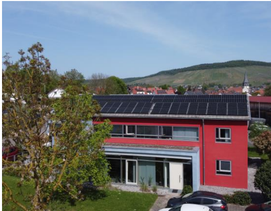
Der AERA-Online Hauptgebäude mit der neuen Photovoltaikanlage
